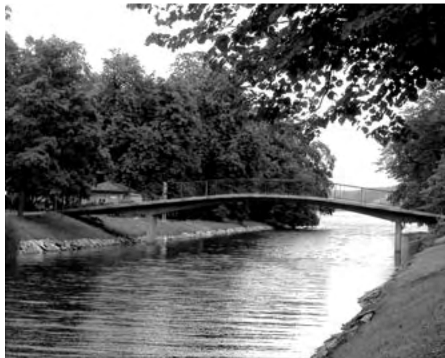
Gång- och cykelbro över Djurgårdsbrunnskanalen.
